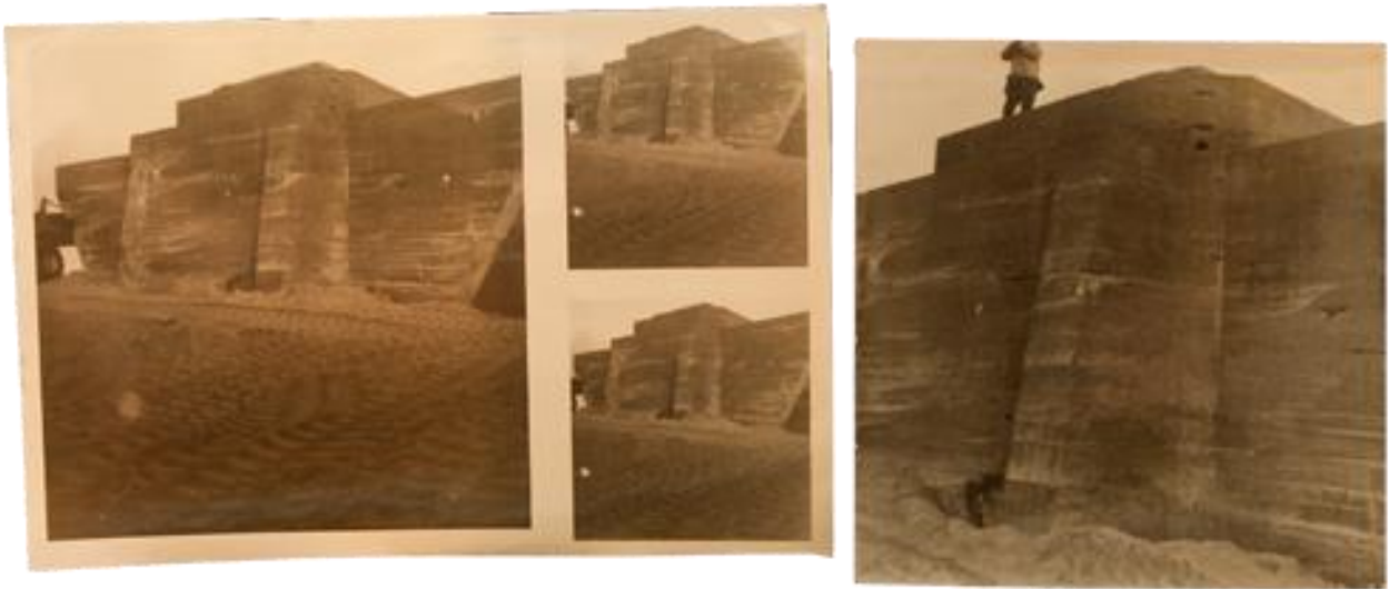
Nieuwe klus die de krant gehaald heeft: De bunker Schier krijgt een grote beurt. Hij staat hier zelf bovenop de bunker
