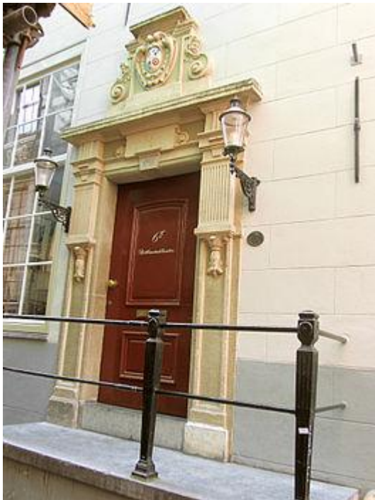
Ingang van het Bethaniënklooster aan Barndesteeg 6b
